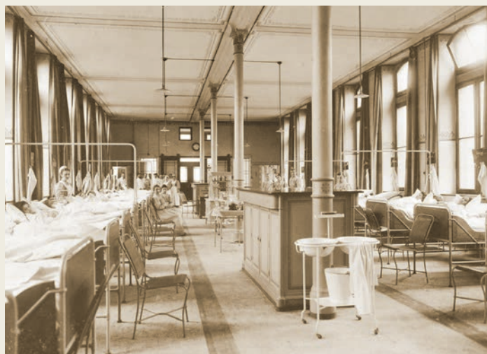
Krankensaal eines Frauenpavillons um 1906
